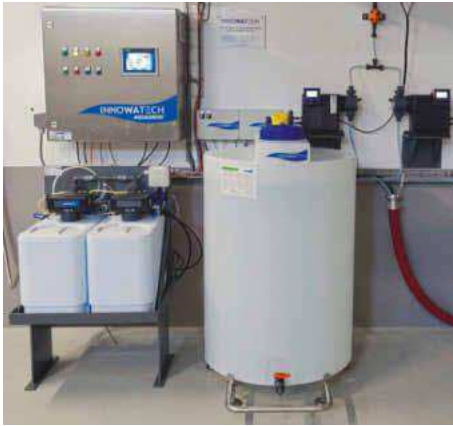
Aquadron-Anlagen produzieren aus Kochsalztabletten und Wasser das gering konzentrierte, pH-neutrale Anolyte
