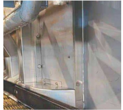
Tunnelpasteur nach der Anwendung von Anolyte zur Behandlung des Prozesswassers
