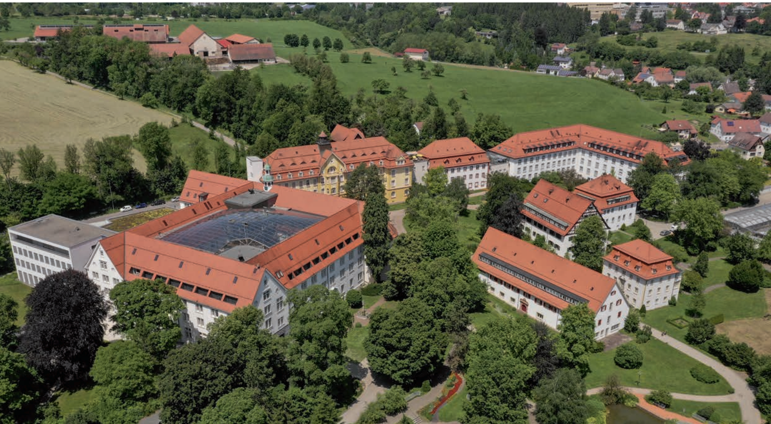
Das Rottenmünster-Areal in Rottweil, das auf eine Klosteranlage aus dem 13. Jahrhundert zurückgeht, beherbergt auf zwölf Hektar Fläche 23 Gebäude. Heute sitzt hier auch das Vinzenz von Paul Hospital, eine Fachklinik mit 467 Betten.
