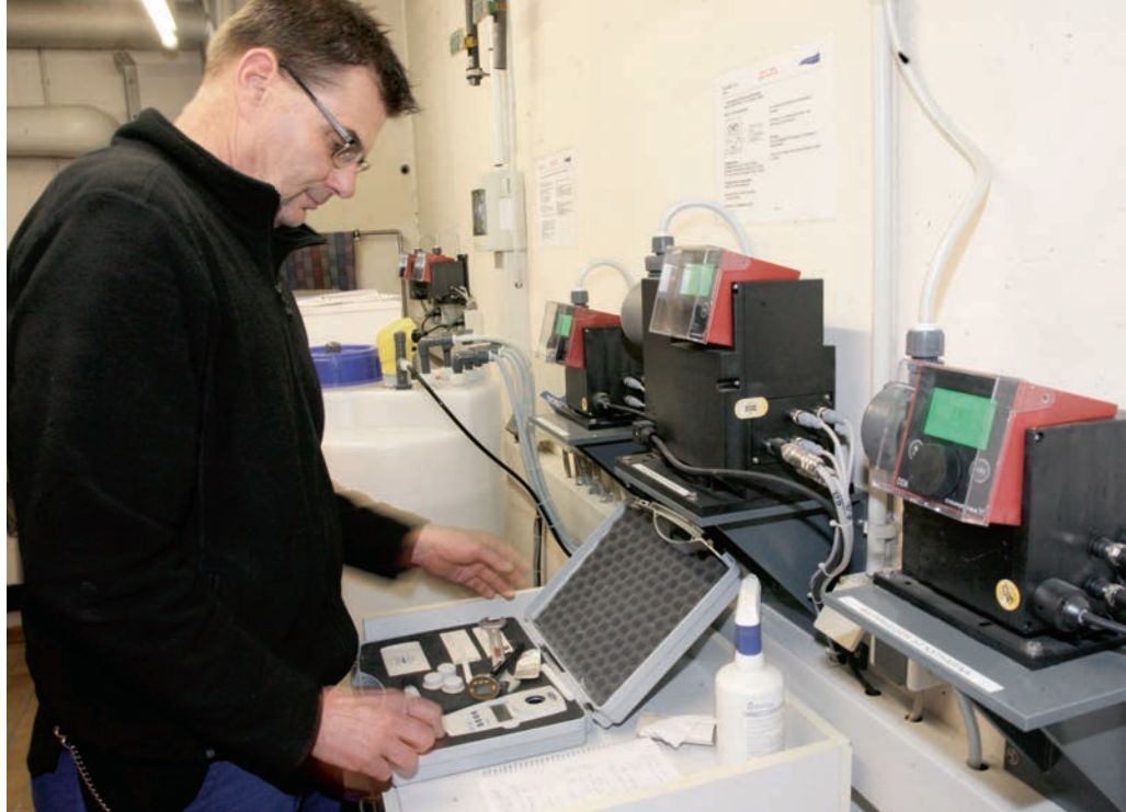
Sicherer Arbeitsplatz dank gefahrstofffreier Desinfektionsmittel-Herstellung aus Kochsalz und Wasser: Werkstatt-Leiter Frank Broghammer bei der Arbeit.
