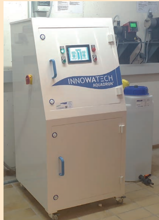
Anlagen der Aquadron-F-Serie dienen der Keimbeseitigung und Prophylaxe in Trinkwassersystemen. Sie stellen direkt vor Ort mittels Membranzellen-Elektrolyse aus Wasser, Kochsalz und Strom das Desinfektionsmittel Innowatech Anolyte her.
