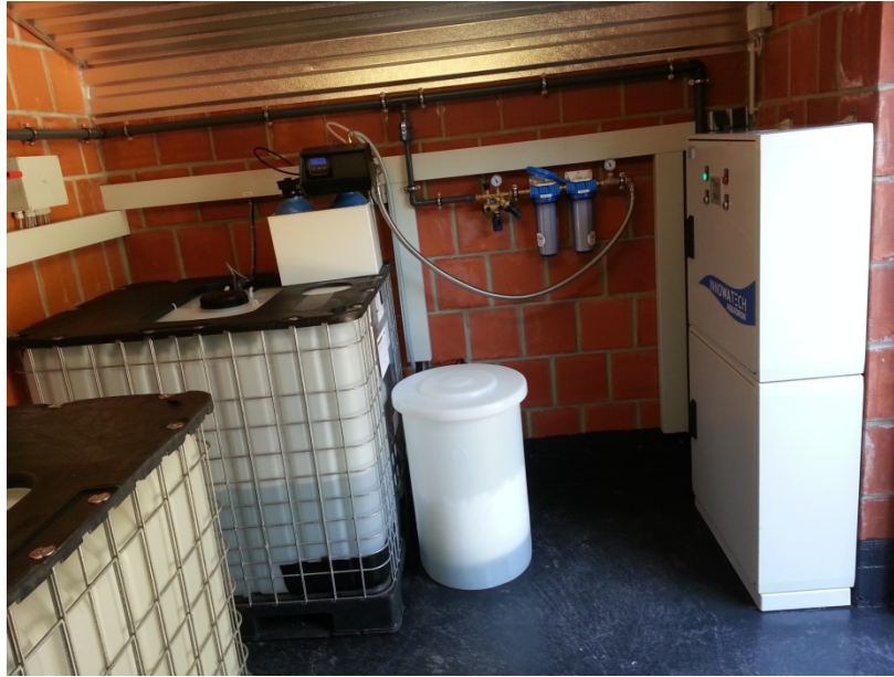
Aquadron KL con Anolyte® - y tanque para Katholyte, contenedor de sal
