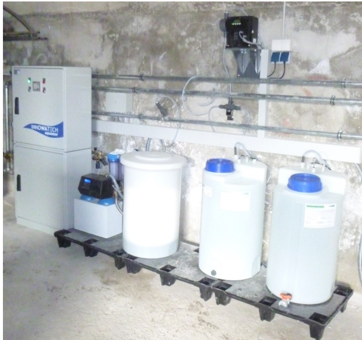
Aquadron KL con tanques para Anolyte® - y Katholyte así como recipiente de sal
