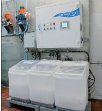
Die industrielle Desinfektionsanlage Aquadron G1 produziert täglich über 1000 Liter Anolyte für die Desinfektion von bis zu 200 m 3 Brunnenwasser und für das Früchtewaschen.
