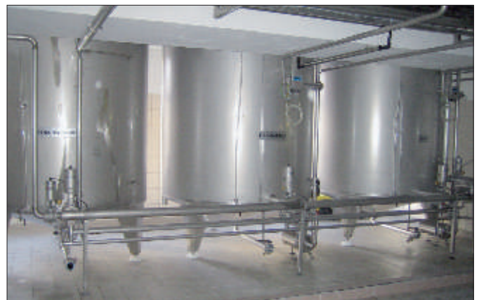
Abb. links: Zylindrokonische Lagertanks mit Leitungssystem bei der Stieglbrauerei – Desinfektion über CIP mit „Innowatech Anolyte“ – Abb. rechts: CIP-Desinfektionstank mit „Innowatech Anolyte“ bei der Stieglbrauerei Salzburg.
