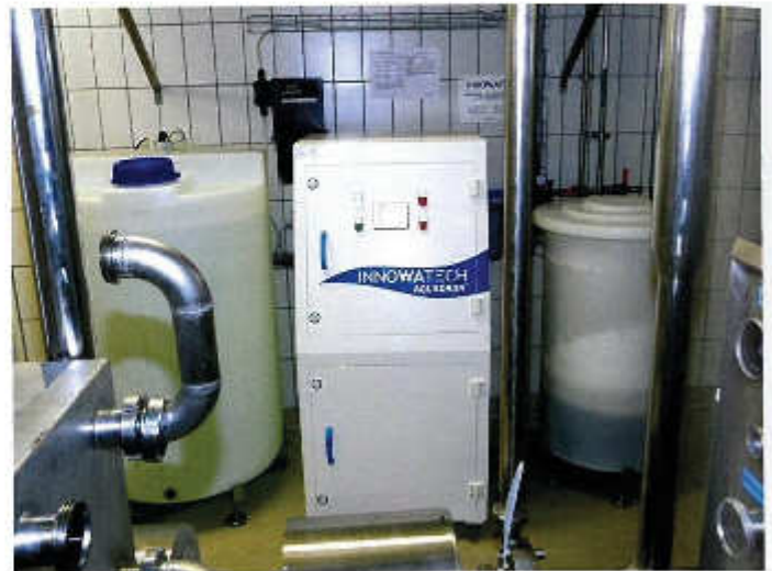
Ein Aquadron-Elektrolyse-Reaktor sorgt bei frischli für keimfreies Brüdenwasser (rechts: Behälter mit Kochsalz, links: Behälter für die Desinfektionslösung)
