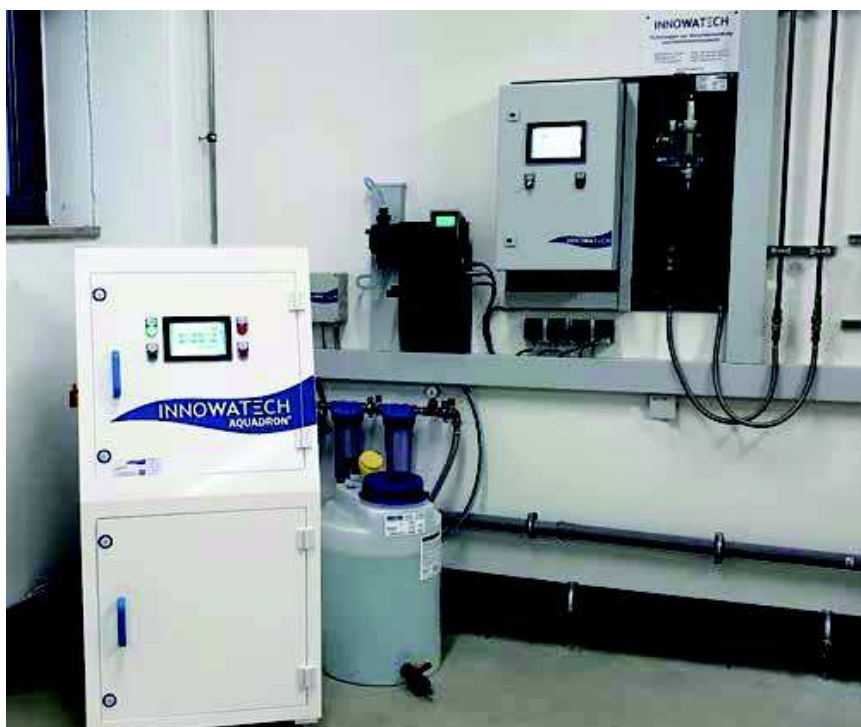
INNOWATECH Aquadron mit Multi-Mess-Center zur Trinkwasser-Behandlung.
