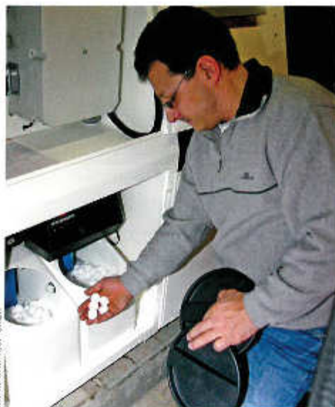
Kochsalz-Tabletten als Betriebsstoff sorgen für geringe Betriebskosten (maximal 0,015 €/m 3 Trinkwasser).
