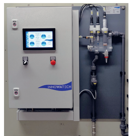
Multi-Mess-Center für die permanente Messung, Auswertung und Verarbeitung sowie Dokumentation der gemessenen Daten
