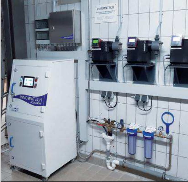
Die Innowatech Aquadron GX K2 produziert ca. 400 Liter Chlorid- und Chlorat-reduziertes Innowatech Anolyte® pro Tag, im Bedarfsfall ist eine Erweiterung auf die doppelte Menge möglich. (Bild: Innowatech)
