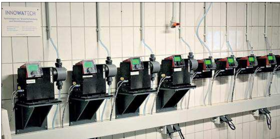
Die vielen verschiedenen Anolyte-Anwendungen bei der Heubacher Brauerei spiegeln sich auch in der Anzahl der Dosierpumpen wider. (Bild: Innowatech)
