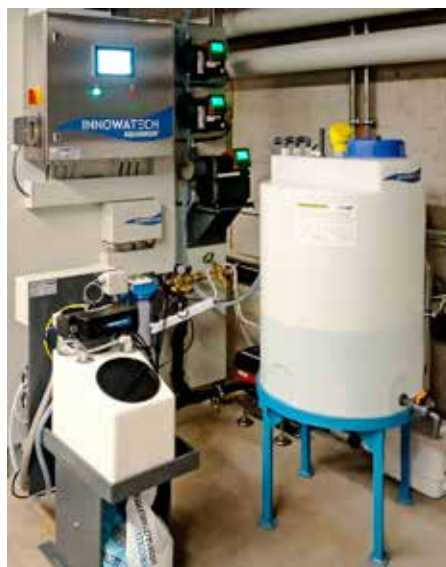
Zeitgemäße Wasserdesinfektion: Die Aquadron CGK-Anlage von Innowatech stellt vor Ort das pH-neutrale „Anolyte“ her.
