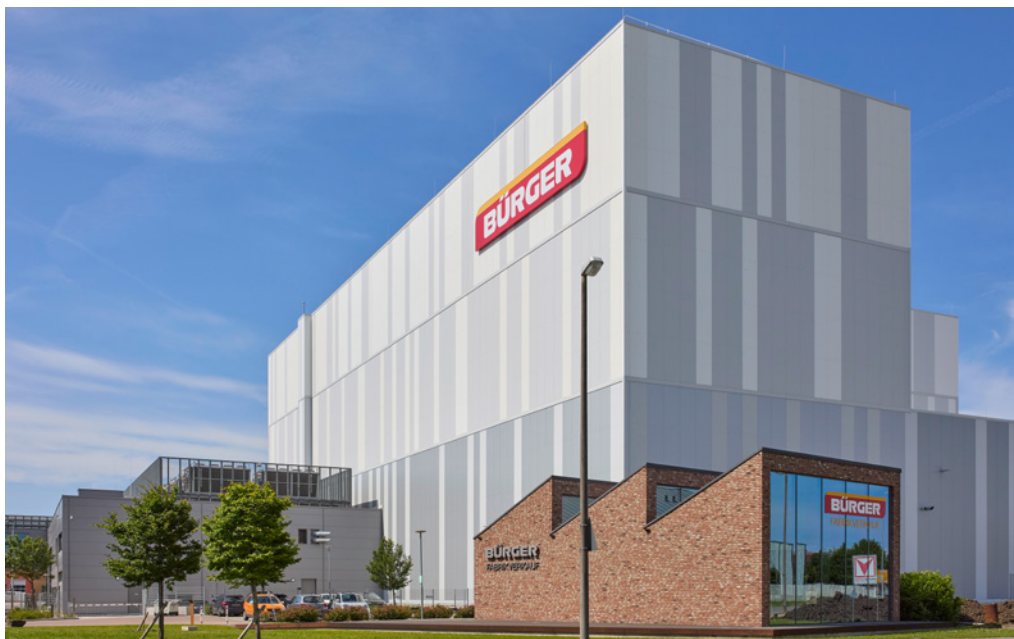
Im vorigen Jahr hat das expansive Unternehmen ein neues Logistikzentrum mit Kältezentrale am Standort Crailsheim in Betrieb genommen.
