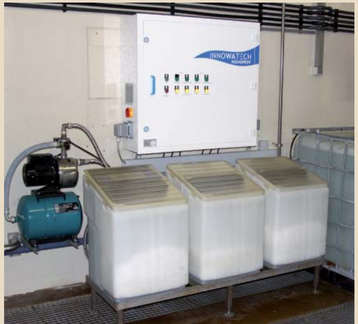
Die Membranzellenelektrolyse-Anlage Type G1 iD
