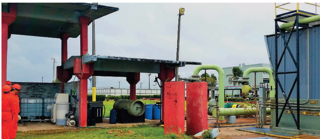
Aquadron PGK, Chlorgasflasche und Kühlturm DE-100
