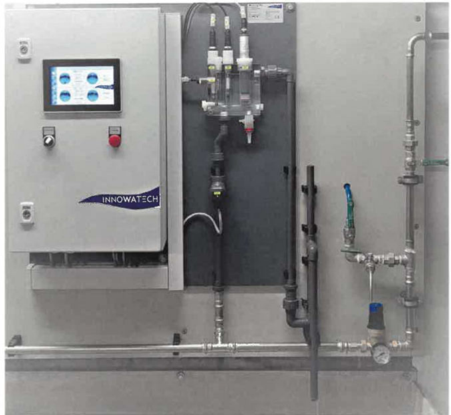
Das Multi-Mess-Center misst permanent den Wirkstoffgehalt im Trink- und Prozesswasser, steuert die Wirkstoffdosierung entsprechend vorgegebener Sollwerte und dokumentiert alle Parameter. Beim Einsatz in Kühlwassersystemen entfallen dadurch die 14-tägigen mikrobiologischen Analysen nach 42. BImSchV.
